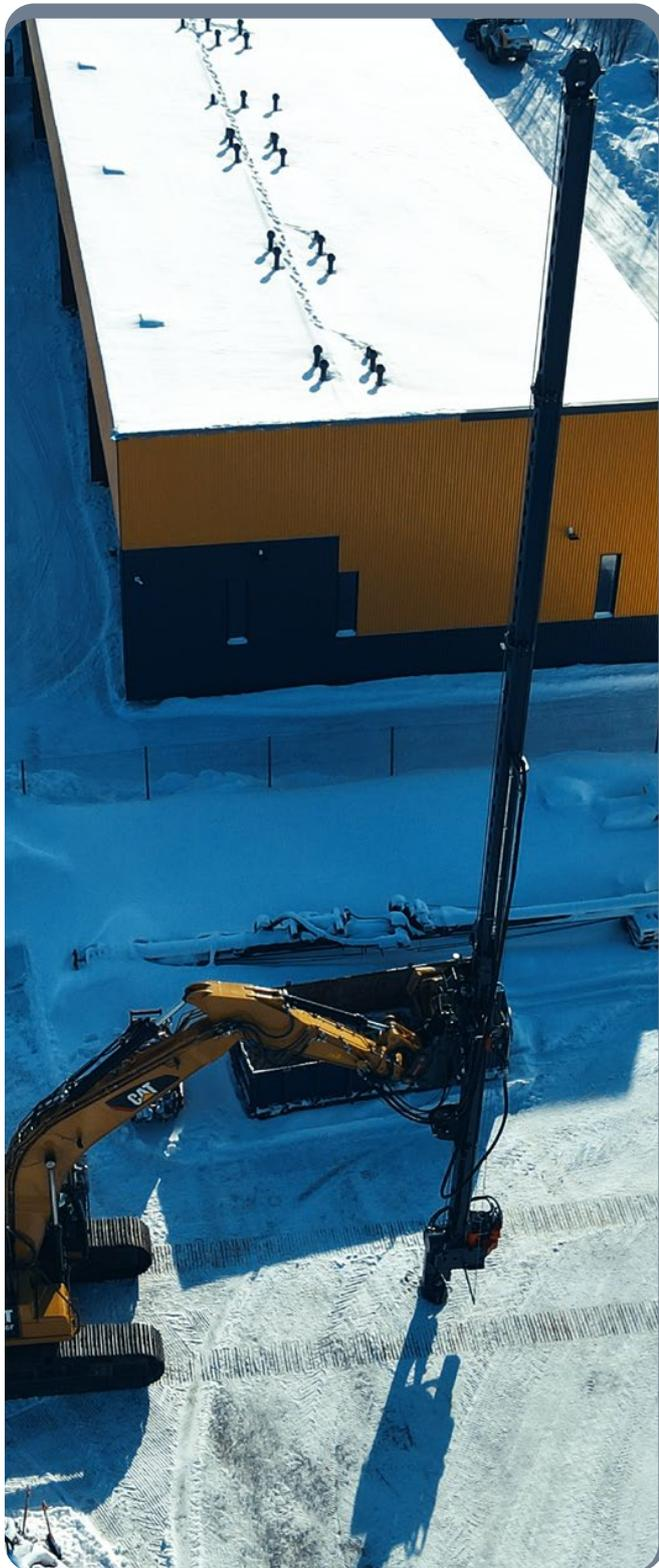
Мачта MOVAX для стабилизации грунта колоннами представляет собой универсальное решение для выполнения стабилизации грунтов с использованием как сухого, так и влажного вяжущего материала.
